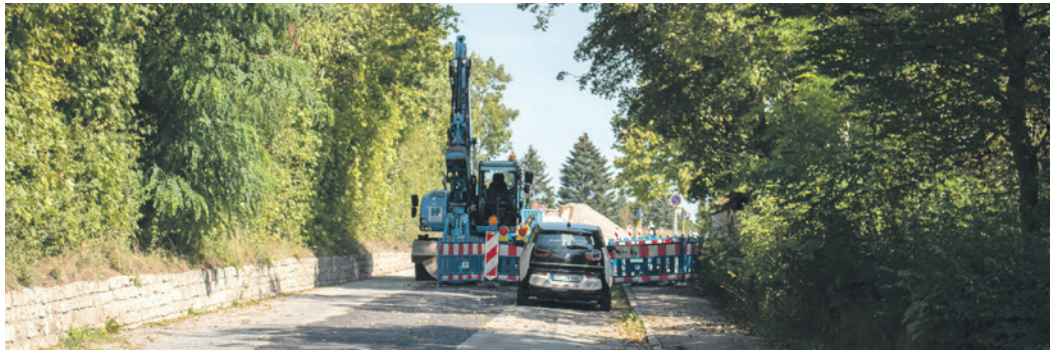
Unter der Urlasstraße verläuft ein Mischwasserkanal, der jetzt saniert wird. Am dunklen provisorischen Asphalt erkennt man den Baufortschritt.
