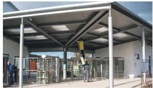
Großzügig und barrierefrei: der neue überdachte Eingangsbereich.
