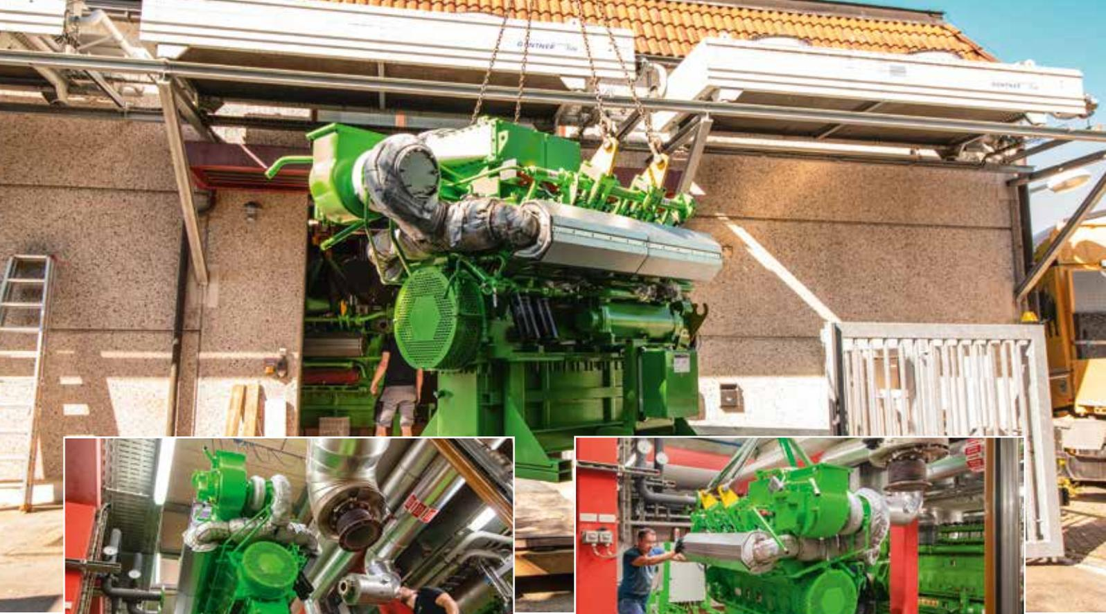
FÜNF TONNEN WIEGT JEDES DER BEIDEN MIT BIOGAS BETRIEBENEN BLOCKHEIZKRAFTWERKE, DIE JETZT IN DIE HEIZZENTRALE AM AQUELLA EINGEBAUT WURDEN.
