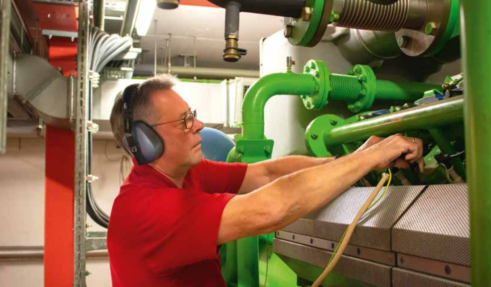
GEHT DEN DINGEN GERNE AUF DEN GRUND: WINFRIED SCHMOLKE HIER BEI DER ZÜNDSPANNUNGSMESSUNG IM HEIZWERK AM STADION.
