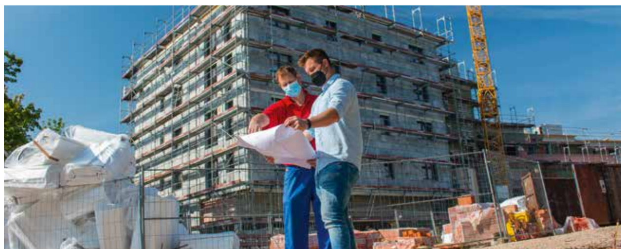
GUNTER SOLDNER (LI.), MONTEUR IN DER ABTEILUNG FERNWÄRME, UND ABTEILUNGSLEITER PHILIP HABERÄCKER PLANEN AM DRECHSELSGARTEN DIE NEUE HEIZANLAGE DER STADTWERKE ANSBACH.
